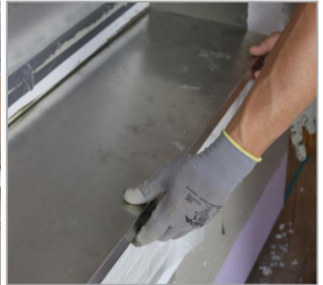
9. Einbau der Fensterbank nach Herstellervorgaben des Fensterbanksystems. Je nach System kann der Einbau erst nach Beendigung der Verputzarbeiten erfolgen.
