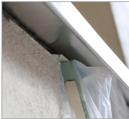
11. Die Tropfenkantenverlängerung kann bei Bedarf nach Beendigung der Putzarbeiten (z.B. bei farbigen Fensterbank- und Putzsystemen) an der Sollbruchstelle entfernt werden.
