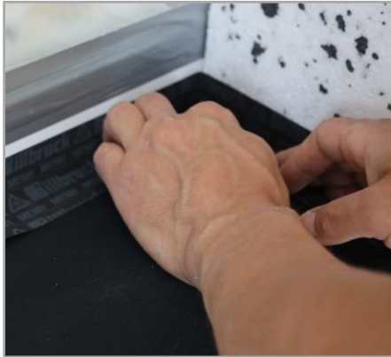
7. Abdichten der Brüstung mit Folien nach Herstellervorgaben des Dichtsystems.
