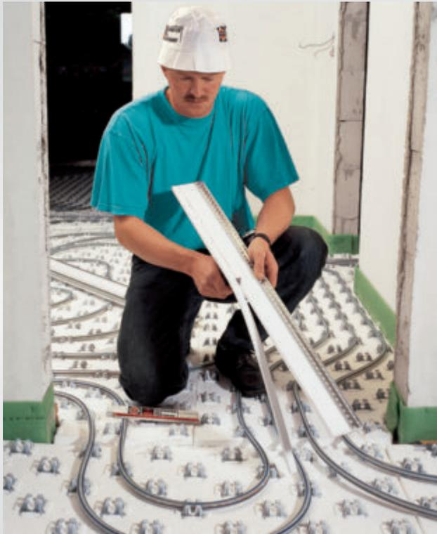
Der PE-Schaumstreifen wird an der Unterkante auf die erforderliche Höhe, entsprechend der Dicke des Estrichs, zurückgeschritten. Anzeichnen und mit Universalklinge schneiden.
