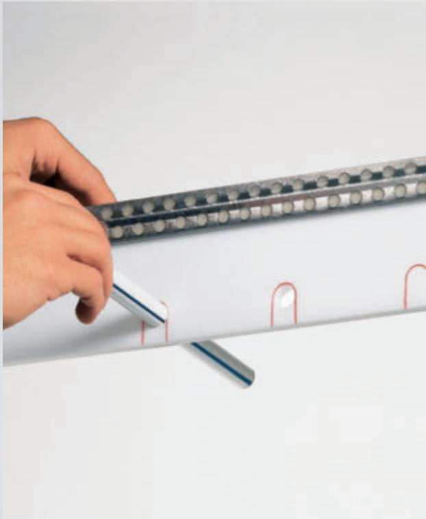
Passgenaue Rohrdurchgänge werden erreicht, indem mit einem Rohrreststück der Schaumstoffstreifen durchstoßen wird. Anschließend Schaumstoffstreifen mit einem geraden Schnitt nach unten durchtrennen.
