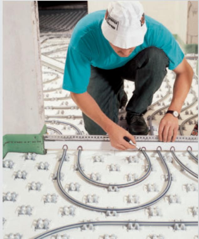
Durchgänge der Heizrohre exakt anzeichnen. Bei Anwendung zwischen Türwangen Profil so ablängen, dass es zwischen den Randstreifen leicht eingespannt wird.
