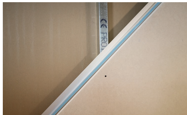
Profilo fissato alla sottostruttura e rivestito secondo le indicazioni del produttore
