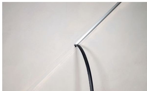
Dopo la verniciatura, rimuovere il tubo protettivo e i residui di vernice e intonaco
